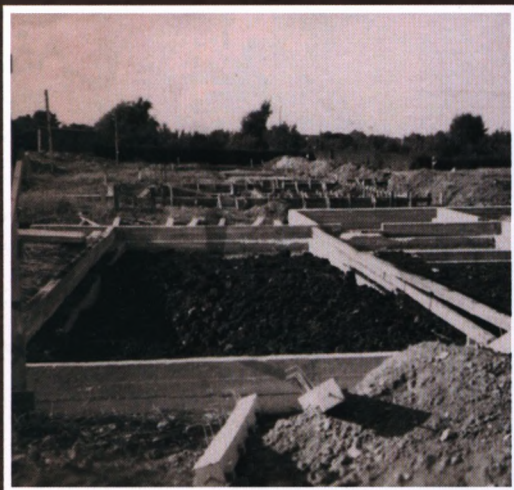
Første fundament på bar mark.
