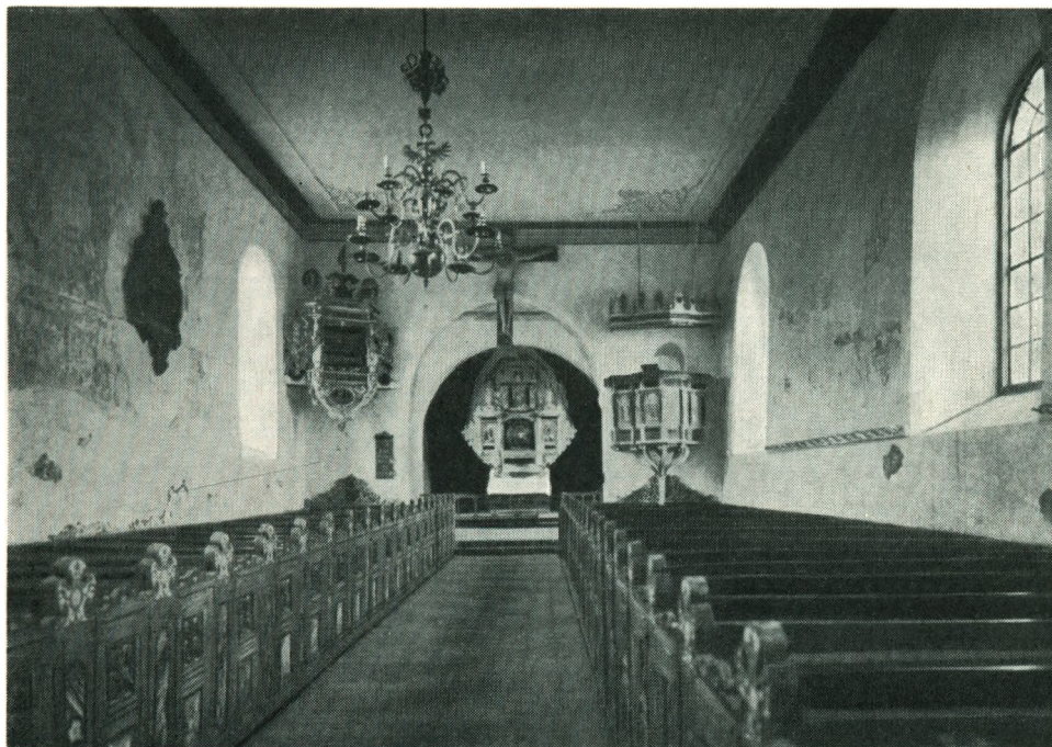
Det indre af Brøns Kirke (1905).
