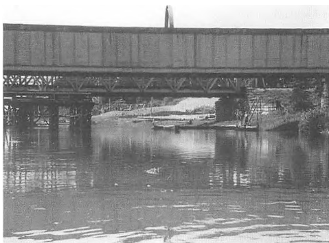
Jernbanebroerne ved Langå, afstivede efter sabotagen den 17. november 1943.
