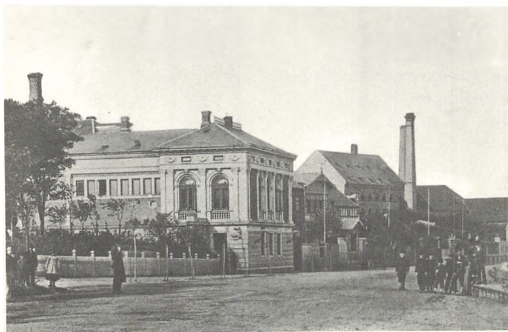
Kystvejen ved Sct. Olufs badeanstalt i 1870erne, efter foto i Århus folkebibliotekets lokalhistoriske samling.
