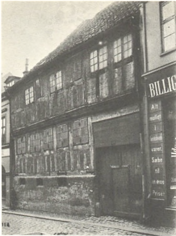
Frederiksgade nr. 15, i mere end et halvt århundrede militærrets sygehus, efter foto i »Den gamle By«. Allerede i 1869 blev der klaget over bygningens brøstfældighed.
