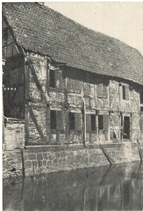
Toldboden før Nedtagningen: Facaden mod Aaen.
