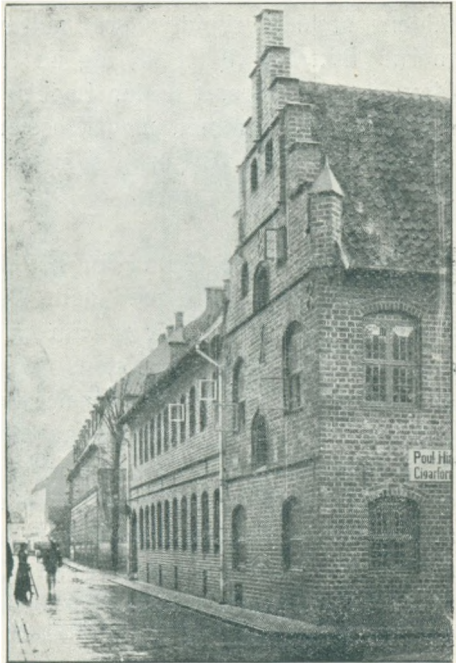
Karmelitterhuset med den berømte Rennæssance-Gavl og Fløjen i Sct. Annægade.
