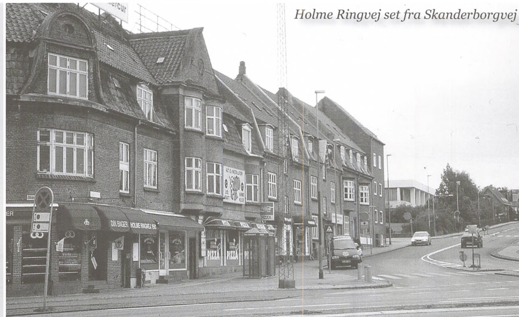
Horsensvej, dengang med brosten
