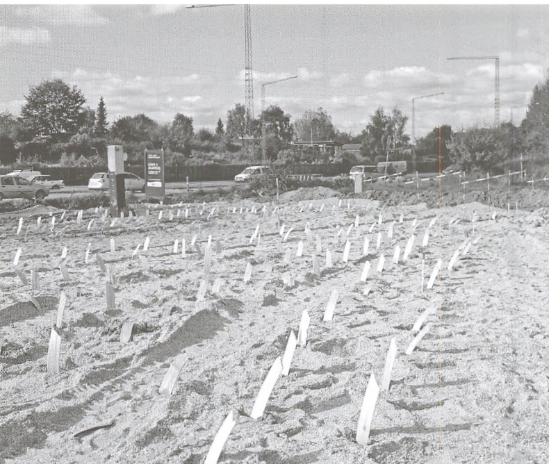
Det var ikke måger, men måleinstrumenter til sænkning af grundvandet FOTO: VEJE & TRAFIK, AARHUS KOMMUNE
