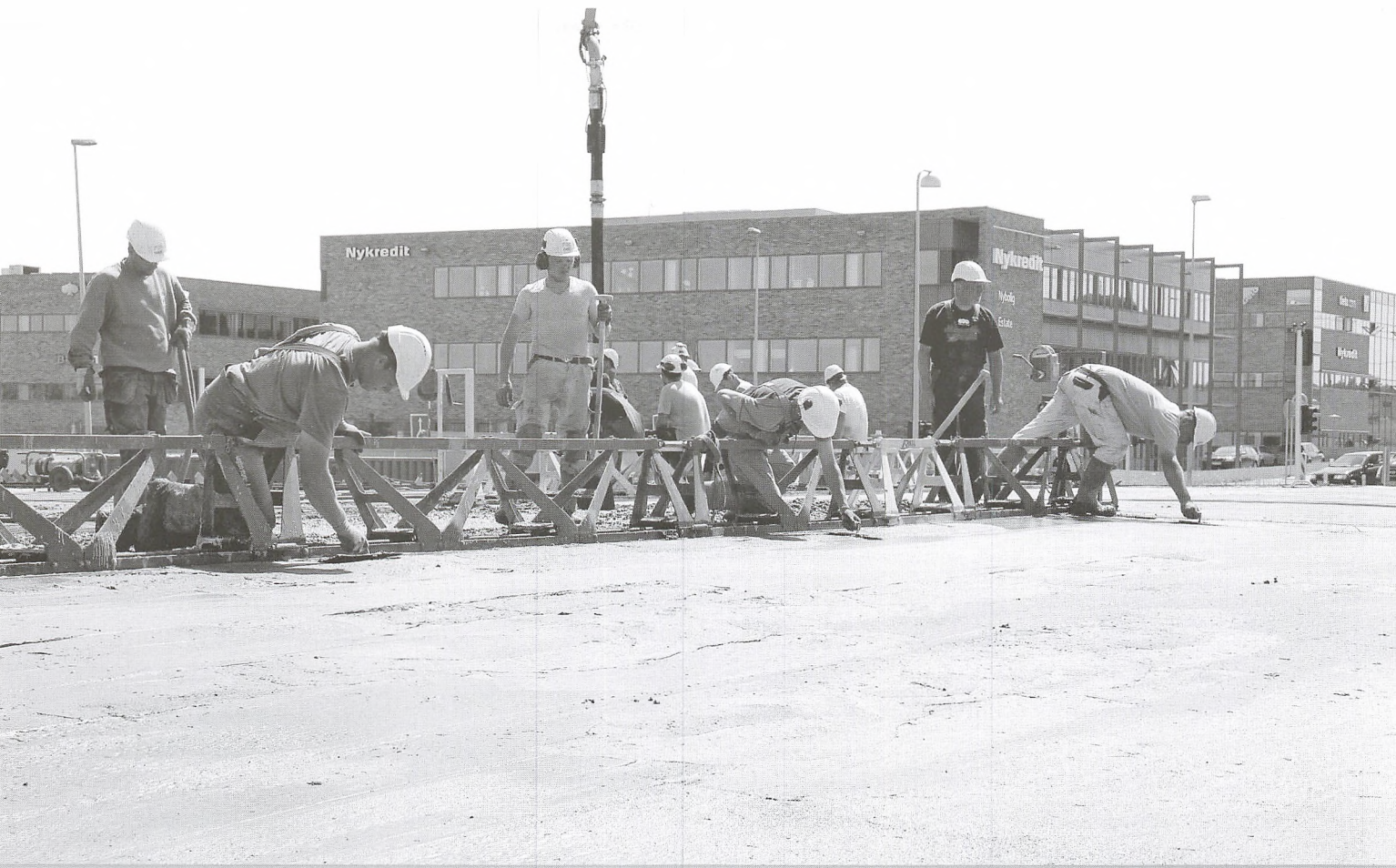
Den håndglattede Ringvejsbro over motorvejen støbes
