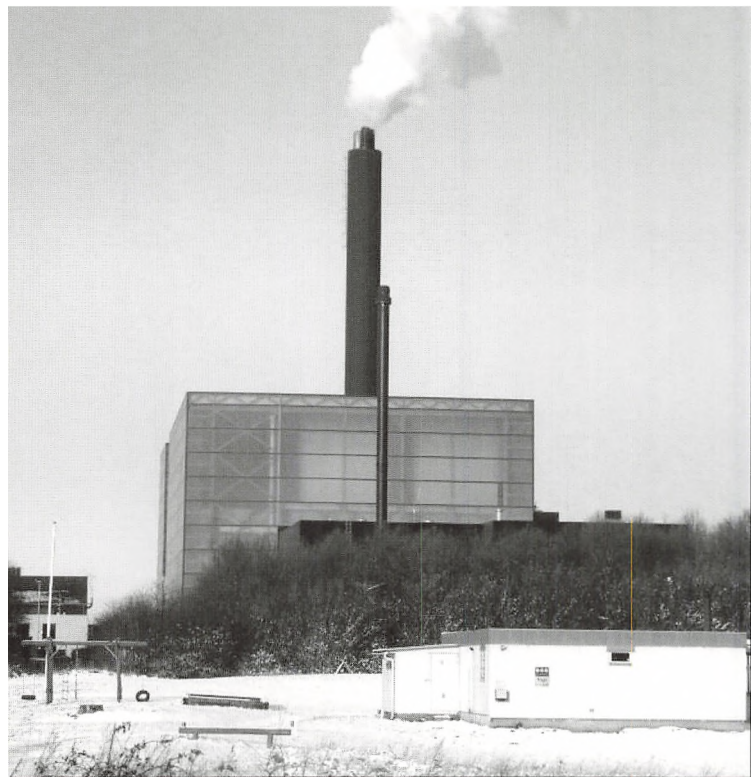
Da forbrændingsanlægget i Lisbjerg åbnede i 1978, ophørte affaldsbehandlingen i Eskelunden.
