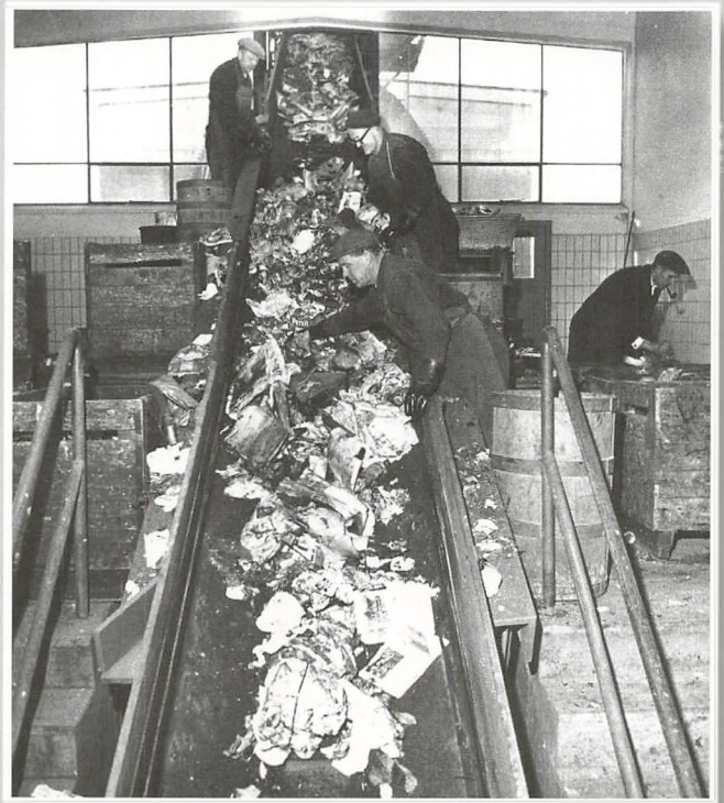
Inden affaldet kom ind i sorteringsanlægget foregik der en manuel sortering på et transportbånd.
