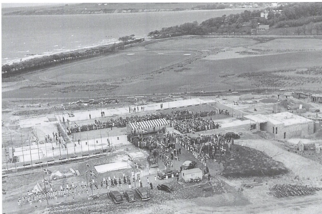
Et vue over Idrætshøjskolen ved grundstensnedlæggelsen.
