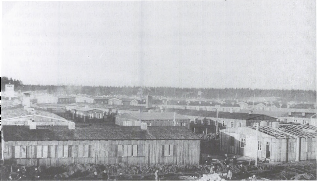
Udsnit af Frøslevlejren 1944-45. Billedet viser opførelsen af lejrens aflusningsbarak. Dengang var Frøslevlejren et trøstesløst område. I dag fremstår lejren indbydende med rødmalede barakker, smuk beplantning, flisebelagte stier, moderne lav belysning og velplejede grønne arealer. Forskønnelsen, som er sket gradvis siden 1950'erne, men især i 1984-89, er blevet foretaget af hensyn til lejrens brugere og mange gæster. Foto: Frøslevlejrens Museum.
