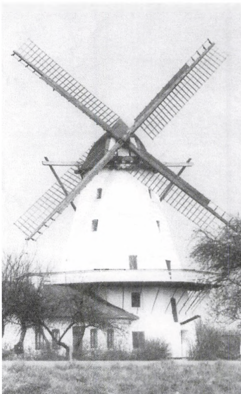
Møllen som den så ud før restaureringen (1982). Alt udvendigt træværk, incl. dele af hatten måtte udskiftes. Foto: Sillerup Mølle.
