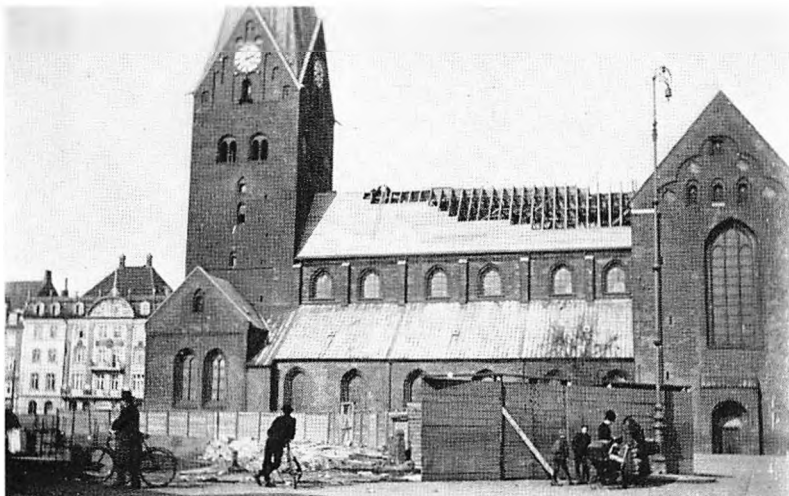
Aarhus Domkirke. Fot. Andersen Ebbesen ca. 1917. I forgrunden det påbegyndte arbejdet på Andelsbuset (se teksten p. 49 f.). Domkirkens skib er ved at få blytaget skiftet ud med tagpap.
