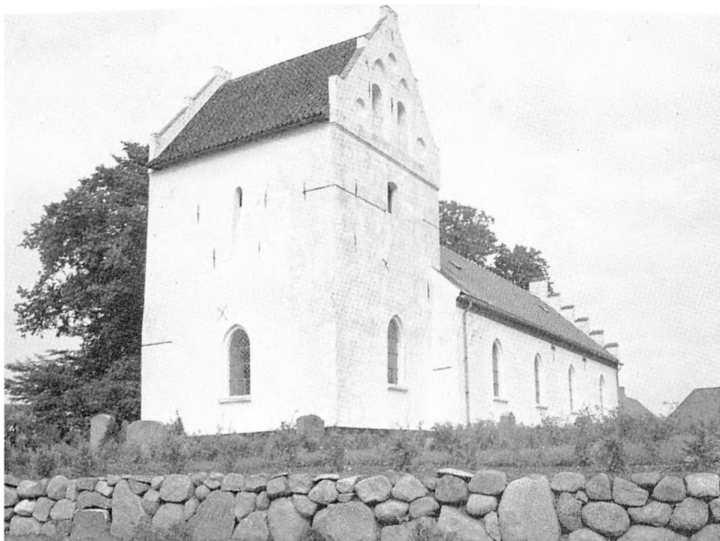
I SØBY VED ASSENS TILSLØRES KIRKENS MIDDLEALDERLIGE BYGNINGSIIISTORIE AF ET DRØJT LAG CEMENTPUDS OG NYE ENSARTEDE VINDUER PÅ RÆKKE OG GELED, ALT FRA 1878. FORF. FOT.
