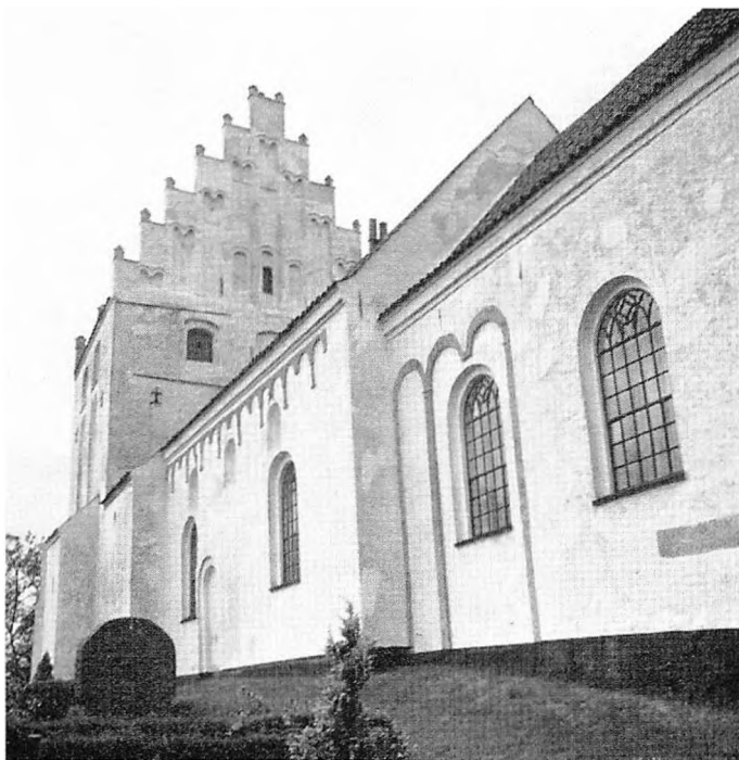
KÆRUM KIRKE. FRÅDSTENSMURVÆRKETS ARKADER OG GESIMSFRISER ER SIDEN ENGELSTOFTS TID AFRENSET FOR KALK. FORF. FOT.
