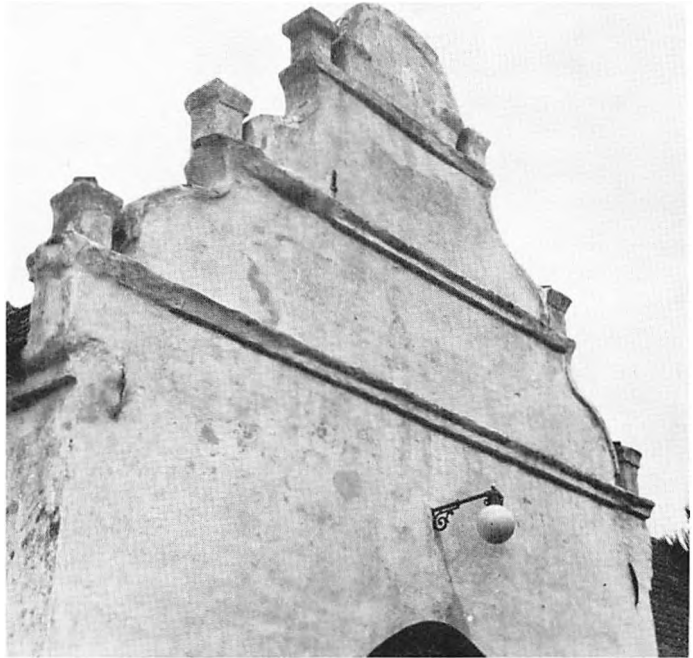
DEN SVUNGNE GAVL PÅ STUBBERUP KIRKES VÅBENHUS MÅ VÆRE OPFØRT I SLUTNINGEN AF 1500-TALLET. FORF. FOT.
