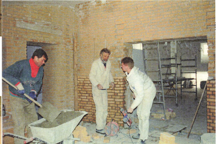
Våbenhuset mures op. Foto: Tornbjerg Kirke.
