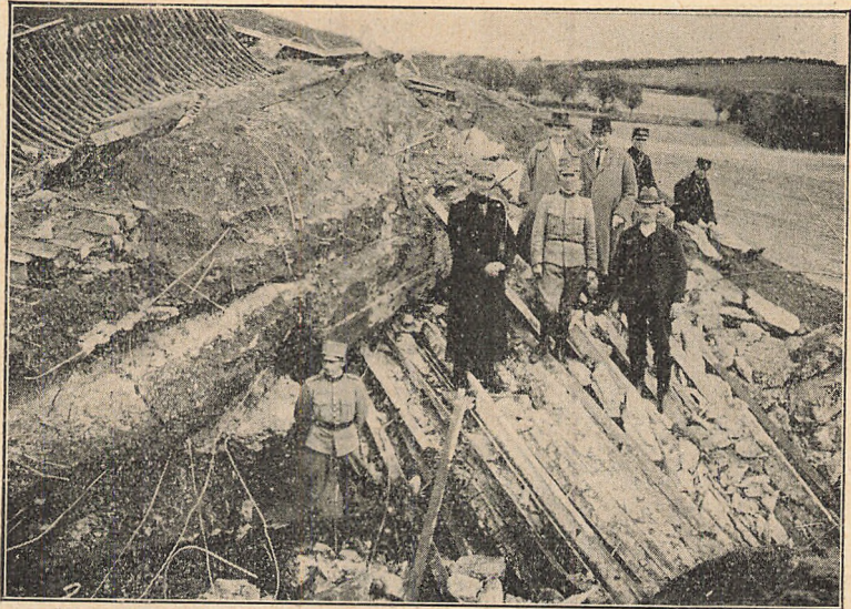
Flankeringen efter Sprængningen.
