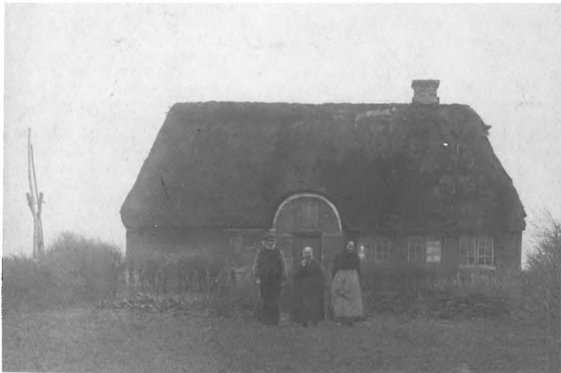
Et af de små steder i Faurlund, bygget af genbrugsmaterialer. Læg mærke til de uens store vinduer og den gammeldags vippebrønd. Personerne er uidentificerede.
