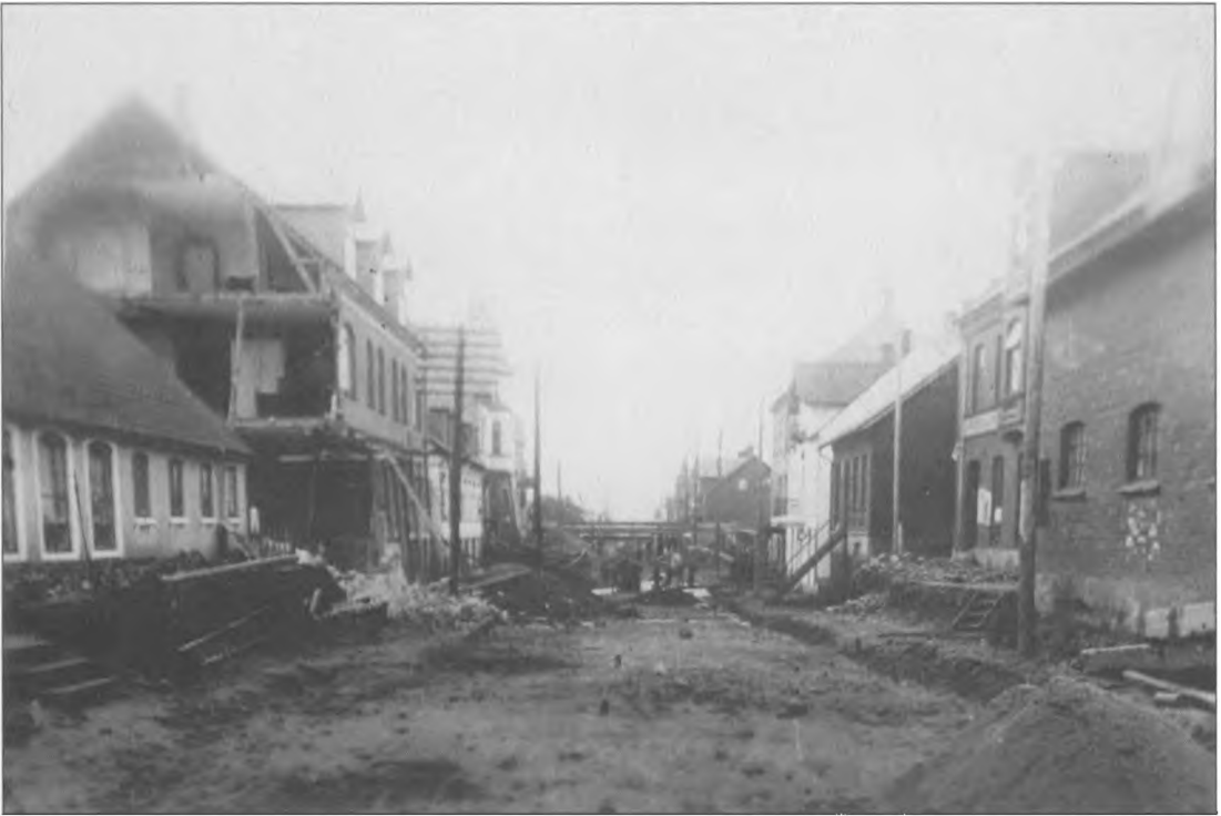
Brørup 1918. Søndergade i opbrud. Gaden blev gravet op og ført som viadukt under banen. Herved vandt enkelte huse nær banen én etage ekstra, til gengæld styrkede gavlparket på det store hus til venstre sammen. Til højre afholdshotellets stald. Foto i Historisk arkiv for Brørup og Omegn.
