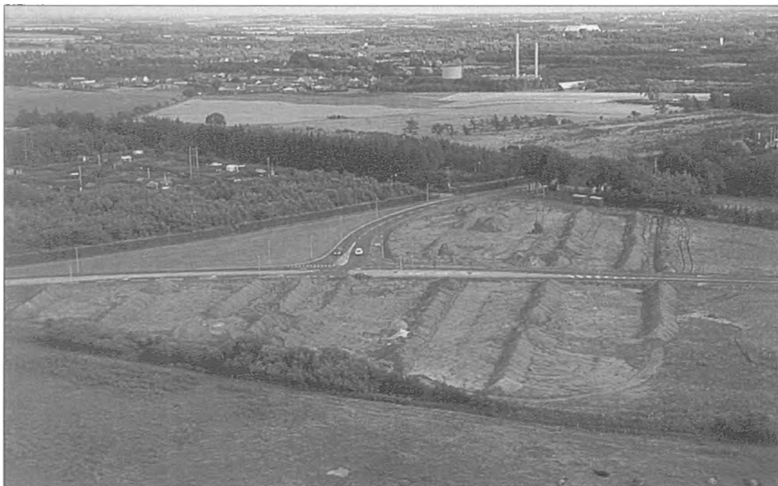
Fig. 1. Luftfoto af udgravningsfelterne ved Kirkebro, set fra nord, med Bramming by i baggrunden. (Foto: A. T. Naamansen).
