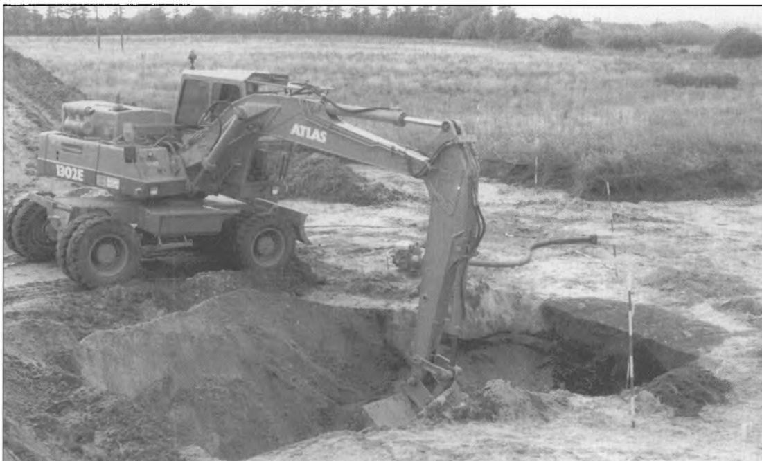
Fig. 8. Udgravning af brønden. (Foto: A.T. Naamansen).
