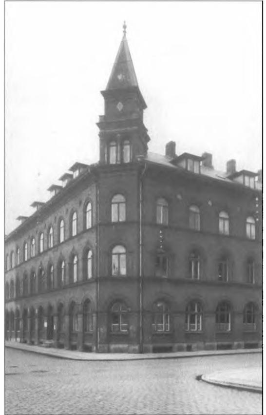
Esbjerg Kommunes administrationsbygning var i brug i perioden 1904-1970
