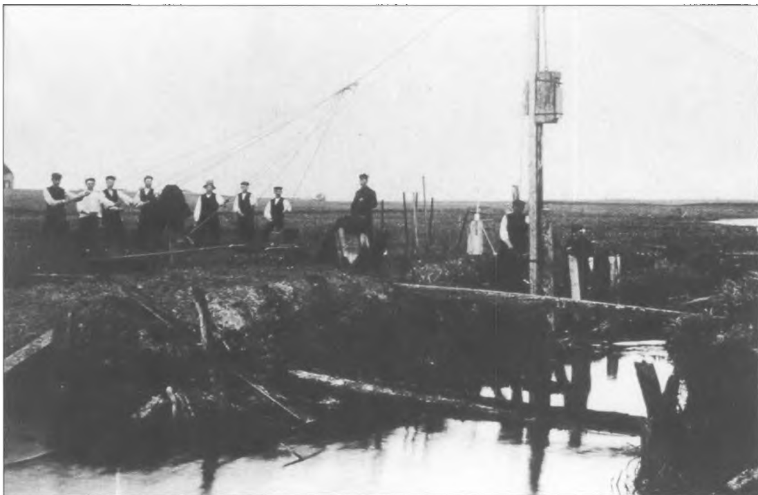
Stemmeværk under bygning øst for Grindsted. Foto 1913. Fremgangsmåder den samme som i 1869
