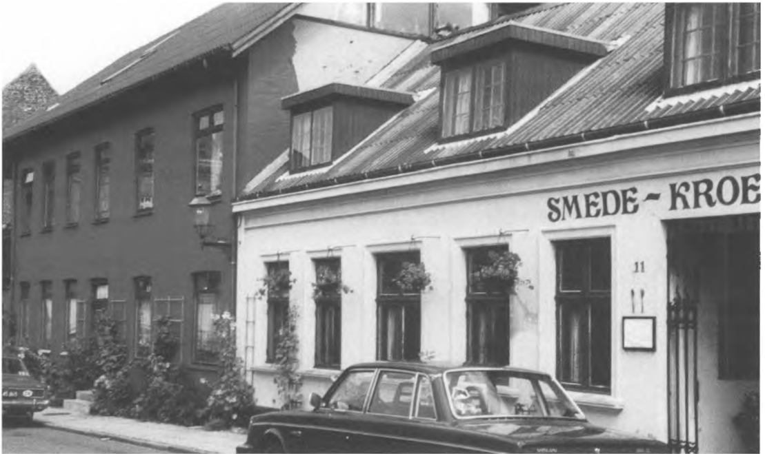
Smedekroen. Smedegade 11, 13 og 15. Indgangen til Smedekroen har gitter af Niels Houllberg. I stueetagen var indrettet kro-stue og på første sal selskabslokale. Det to en halv etages hus var en del af Smedekroen og rummede smedens Stue, Terrassestuen, Mellemstuen og Bjælkestuen. Yderst til venstre i billedet ses den åbne terrasse. Foto: Esbjerg Byhistoriske Arkiv.
