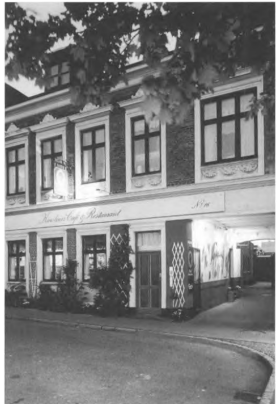
Jyllandsgade 16, Esbjerg 1981. Forhuset rummede Karolines Café og Restaurant og Margreth og Helge Plougs lejlighed på første sal. Gennem porten ses baghuset med Marinestuen og Vævestuen. Foto: Esbjerg Byhistoriske Arkiv.
