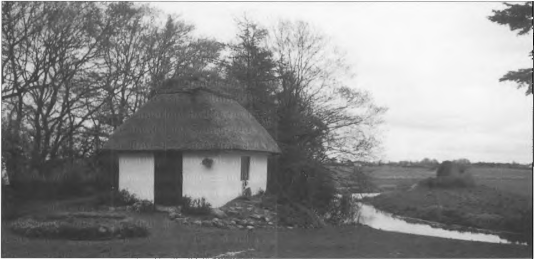
Ovnhuset, hvor bageovnen i gamle dage var installeret i haven til den fredede gård Nybro, Gl. Skolevej 40.
