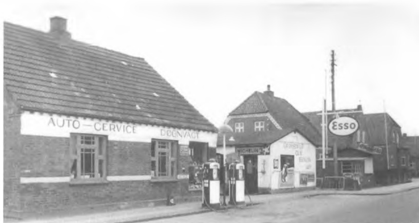
Grimstrup by med Esso stationen som det så ud i 1950'erne. Foto i Grimstrup Lokalarkiv.
