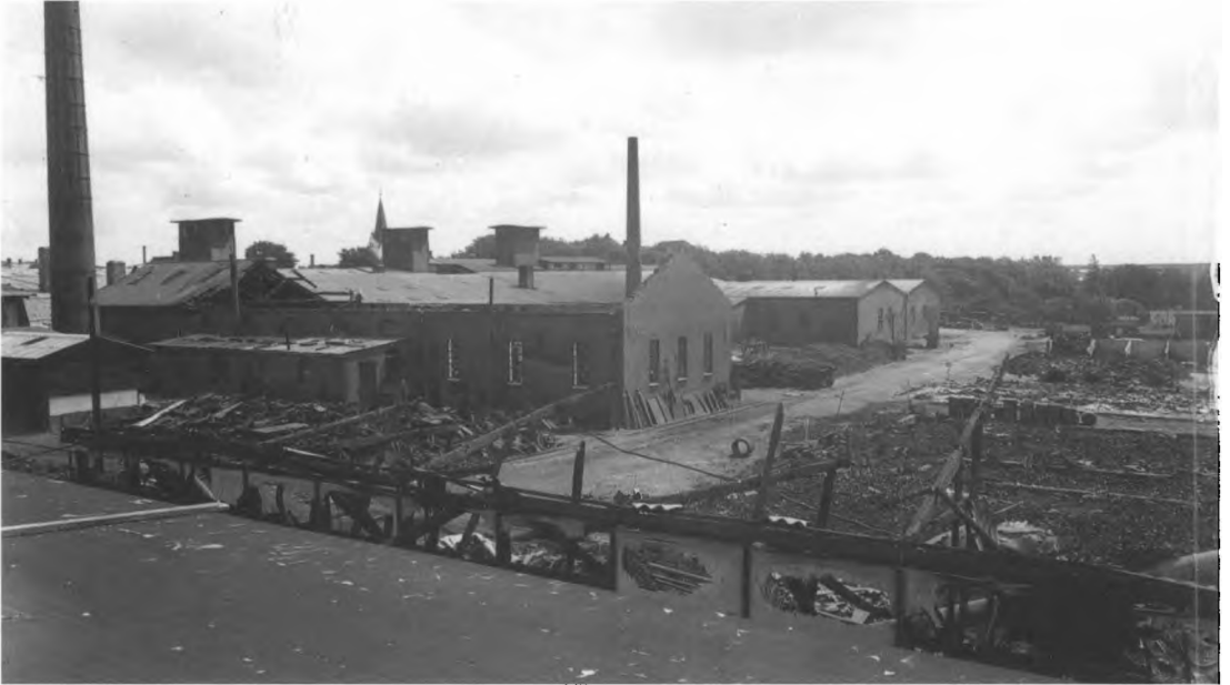
Udsigt over Varde Staalværk efter branden den 4. juli 1943. Modellagrene har ligget til højre i billedet. (Varde Lokalhistoriske Arkiv).
