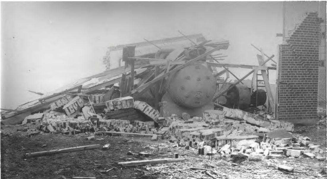
Kompressorrummet efter sabotagen den 12. december 1943. (Varde Lokalhistoriske Arkiv).
