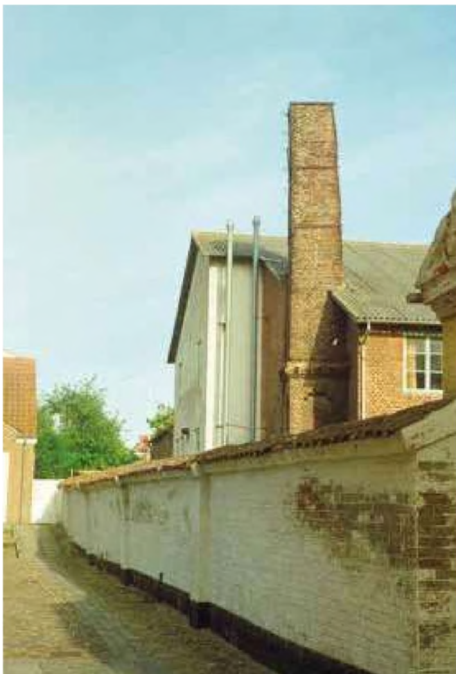
Fabriksskorstenen i Slotsgade umiddelbart før nedrivningen. Foto: Jens Bruun-Petersen, Grønnegade.
