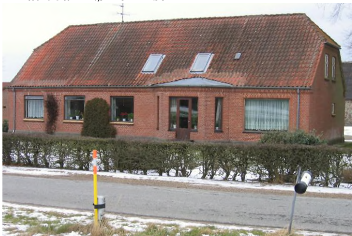
Billedet er taget februar 2009 og fra Hvalpsundvej Bemærk kampestensmuren – bagest
