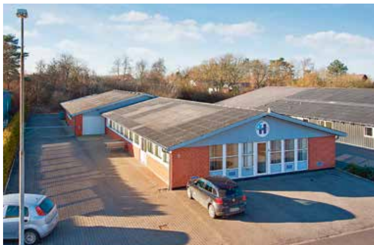
Her, i virksomheden Halcos tidligere bygninger på Fabriksvej 8 i Struer, skulle der have været indrettet katolsk kirke med tilhørende faciliteter. Det bliver imidlertid ikke til noget. Foto: Nybolig Erhverv Vest.
