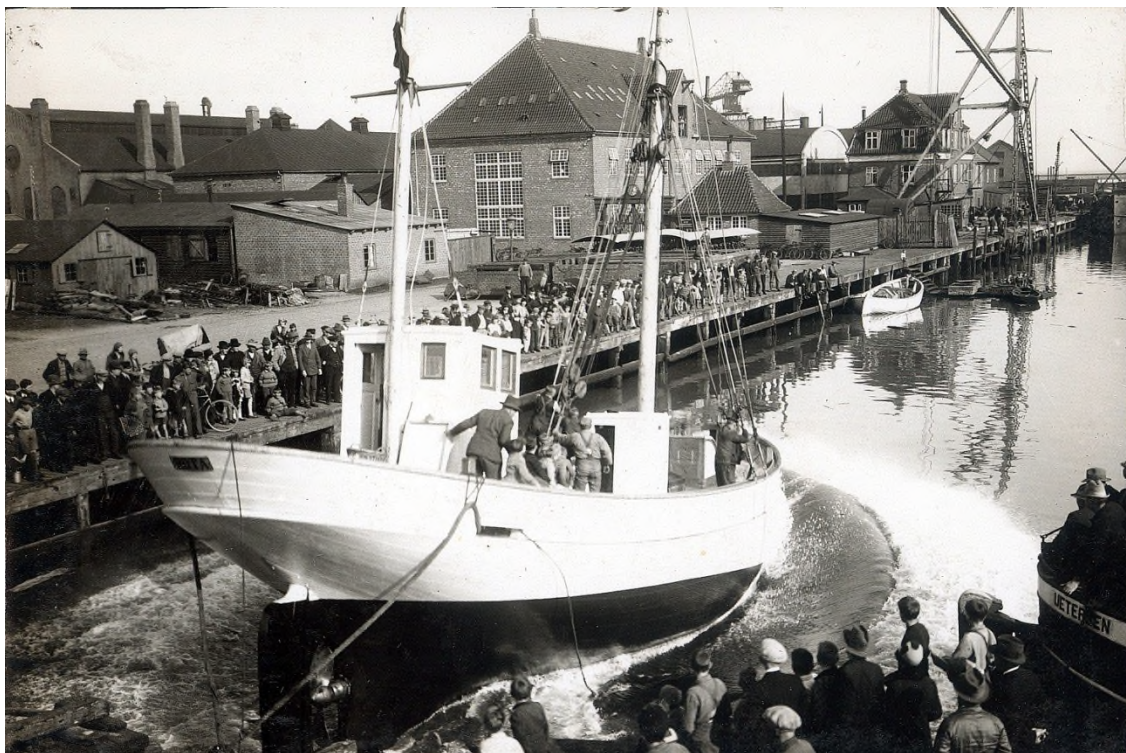
Søsætning af nye fiskekuttere trak altid mange folk til havnen. Her ses i 1931 kutteren ROTA, der var bygget på træskibsværftet Hjørne & Jacobsens Skibsværft. Værftet benyttede ikke en byggebedding med udløb i havnen, men benyttede en vogn, som blev trukket tværs over havnepladsen til et slæbested. Herfra søsattes så kutterne uden at vognen havde direkte kontakt med vandet. I baggrunden ses Frederikshavn værftis maskinværksted, smedje og tømrerværksted. Rundbuehallen er værftets skibsbyggeri. Foto af Herluf W. Jensen i Bangsbo Museum og Arkiv.
