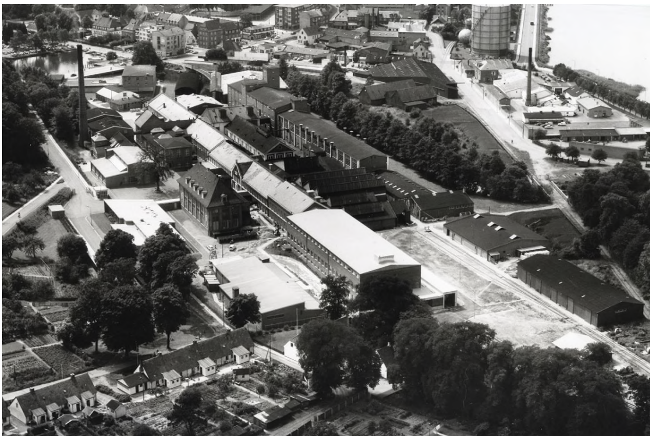
Luftfoto af Silkeborg Papirfabriks anlæg i 1962. I baggrunden til venstre ses Havnen og øverst til højre byens gasværk. Her ligger i dag rådhuset. Foto: Silkeborg Arkiv.
