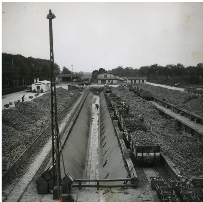
Sukkerindustrien krævede massiv arbejdskraft. I 1930'erne blev sukkerroerne stadig læsset ved håndkraft. Her Maribo Sukkerfabriks flyderender. Foto: Museum Lolland-Falster.
