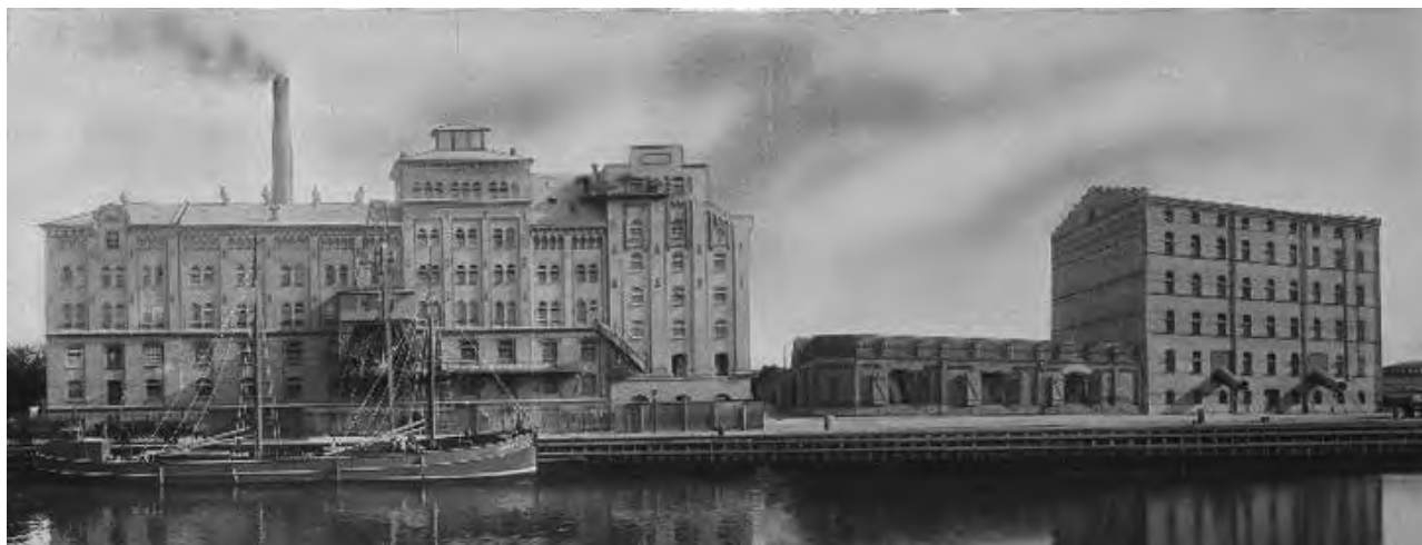
Malmø af Stora Valskvarn, 1904 til venstre i billedet er opført 1881 som et vigtig led i etableringen af Københavns Dampmøller A/S (færdigbygget 1885). Bygningen til højre i billedet (Blanderiet) er opført i 1902. Rud. Schmidt blev selskabets første direktør og fungerede som direktør 1881-1889.(Malmø Museum)
