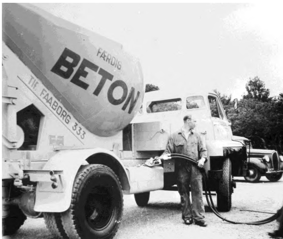
Et af landets største områder for transport er byggeri og anlæg. Her køres de største mængder, men da turene er korte, overgås området dog af kørsel i forbindelse med landbruget. Her er en betonkanon ved at blive tanket i Faaborg. Foto fra Faaborg Byhistoriske Arkiv.
