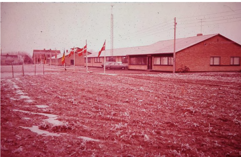
Fjernsynsfabrikken i Pandrup blev i 1958 bygget i lyn tempo, "Pandrup-tempo". Øverst ses Falck, der hjalp med at montere gitterspærerne. I midten ses håndværkere og investorer, der andægtigt lytter til sognerådsformandens ved rejsegildet, og nederst ses fabrikken med flagalle ved indvielsen. Privatfotos.
