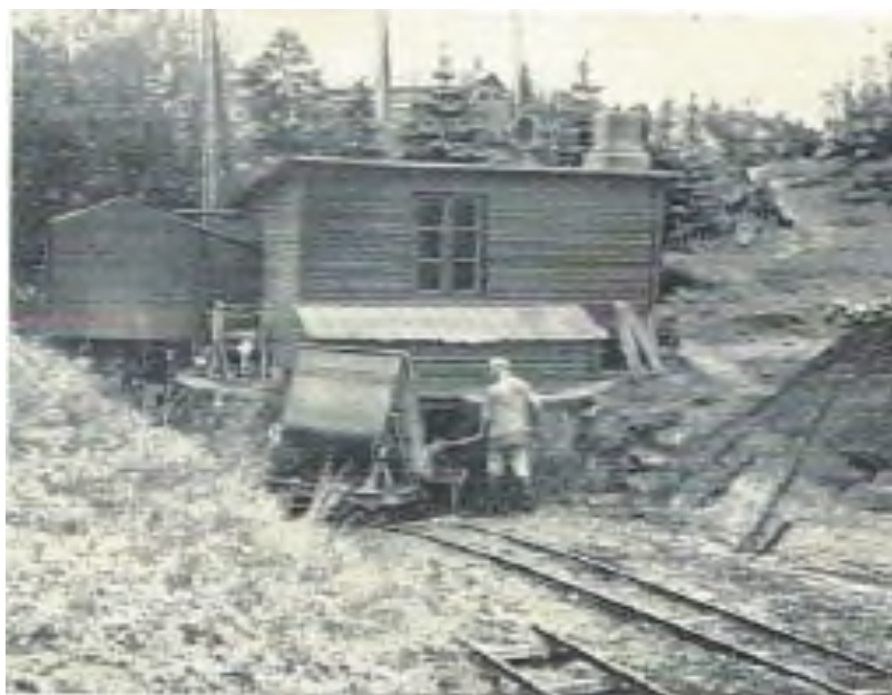
Okkerværkets bestyrer, Christoffer Hansen, skovler råokker fra tipvognen ned i slemmekarret. Den lille værkstedsbygning med skorsten ses ovenpå slemmekarret. Udsnit af pjecen Farve af fra den danske jord (se s. 62).
