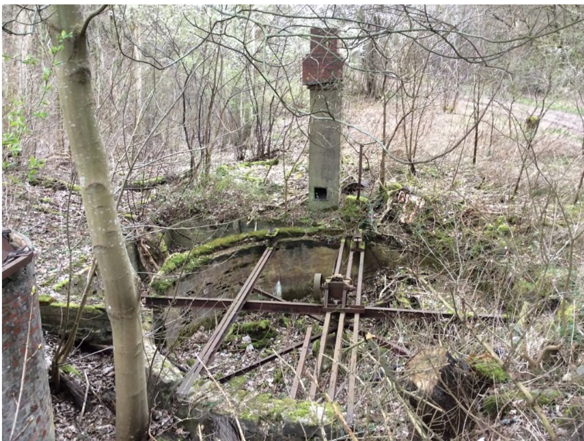
Rester af "Slemmen". Her i den runde beholder blev råokkeren rensset for sten og andet materiale. Et lille værksted af træ stod ovenpå Slemmen. Skorstenen, der hørte til værkstedet, står stadig tilbage. Foto: Forfatteren.
