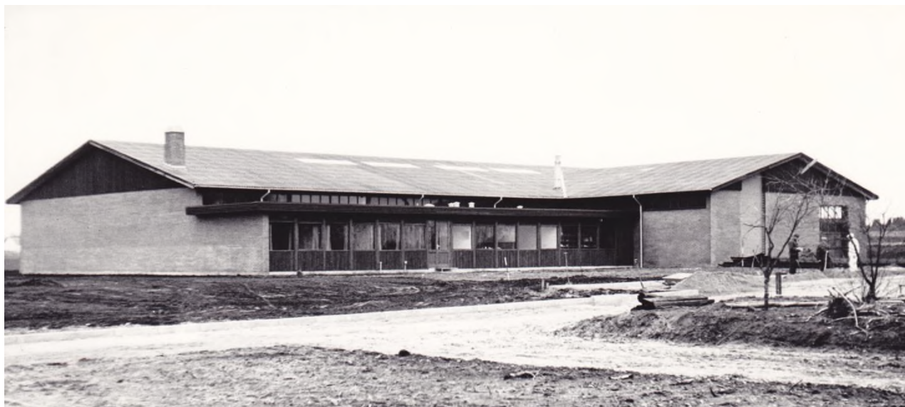
Fabrikant Chr. Havemoses virksomhed på Svoldrupvej 18 fotograferet lige efter indvielsen i 1967. Fotograf ukendt. Lokalthistorisk Arkiv for Farsø og Omegn.
