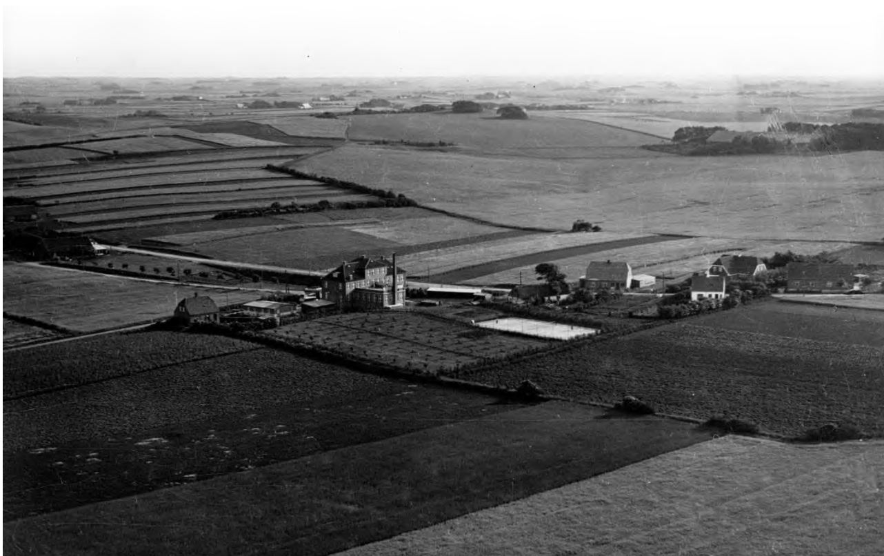
Bang & Olufsens første fabrik fra 1927. Fabrikken blev sprængt ved schalburgtage i 1945, hvorefter en ny fabrik blev bygget på samme grund. Foto: Struer Museum.
