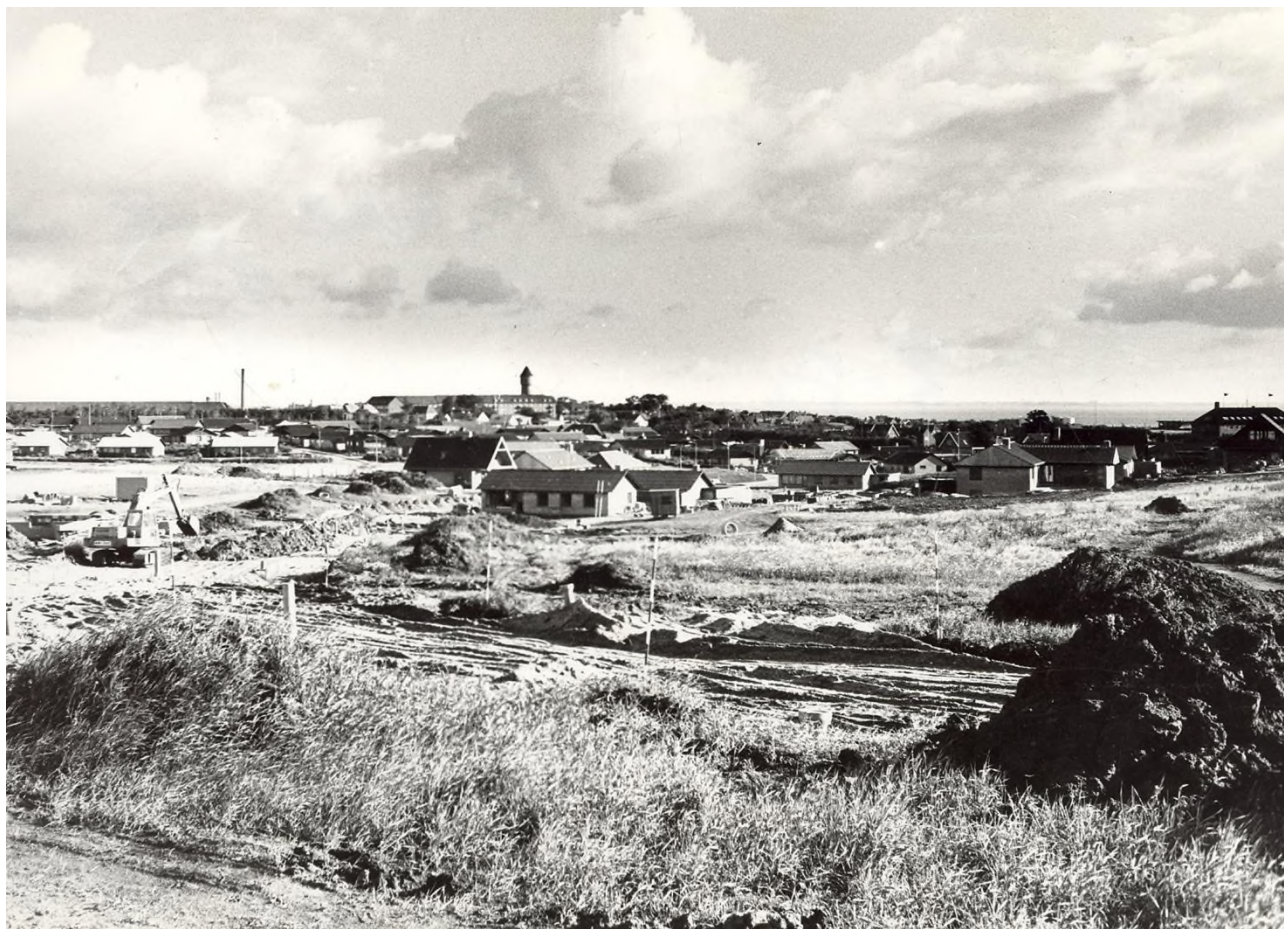
Byggemodning af grunde i Gimsing. Foto: Struer Museum.
