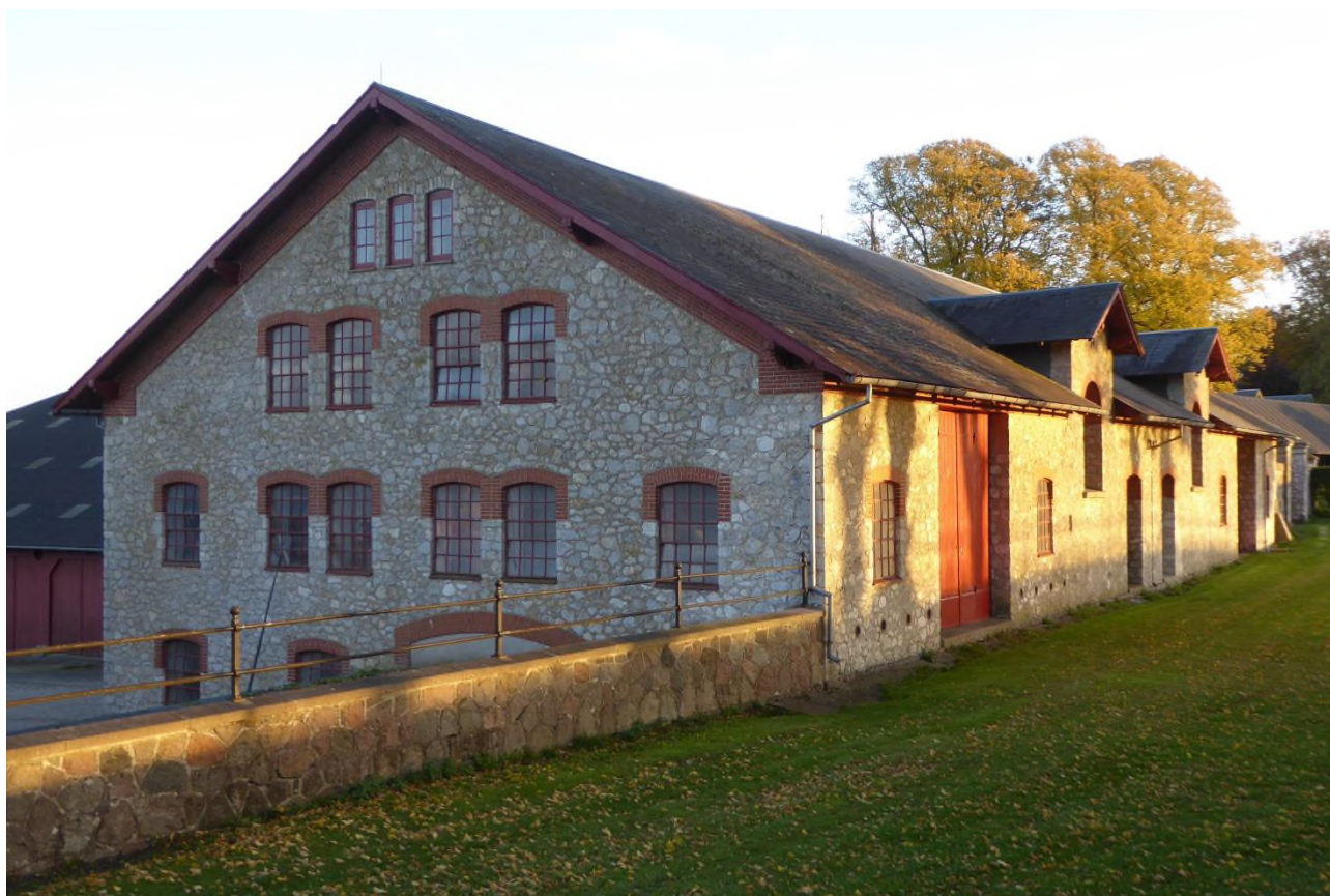
Der er brugt kalk til opførelsen af mange ældre og nyere bygninger i området omkring Faxe. F.eks. indgår der kalk i bygningskomplekserne for både Bregentved, Rosendal og Vemmetofte – tre godser, som til sammen ejede en meget stor del af kalkbrudsarealerne indtil 1884. Her er det en af Bregentveds store avlsbygninger fra 1880'erne. Foto: Jørgen Mikkelsen.
