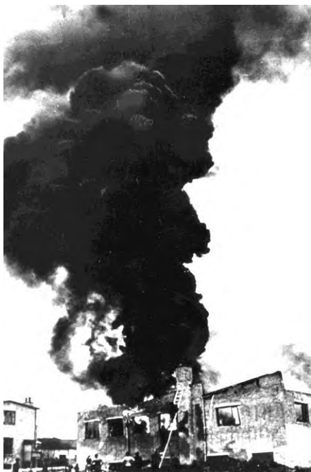
Et utal af brande og eksplosioner hjemsøgte Cheminova de første årtier. Brandvæsenet kunne ikke stille meget op, da fabrikken første gang brændte i maj 1941. Den største fabriksbygning brændte ned til grunden, da en medarbejder kogte tjære, og hvor kedlen kogte over. Den lukrative produktion af erstatningsvarer var dog i gang igen dagen efter (Gladsaxe Byarkiv).
