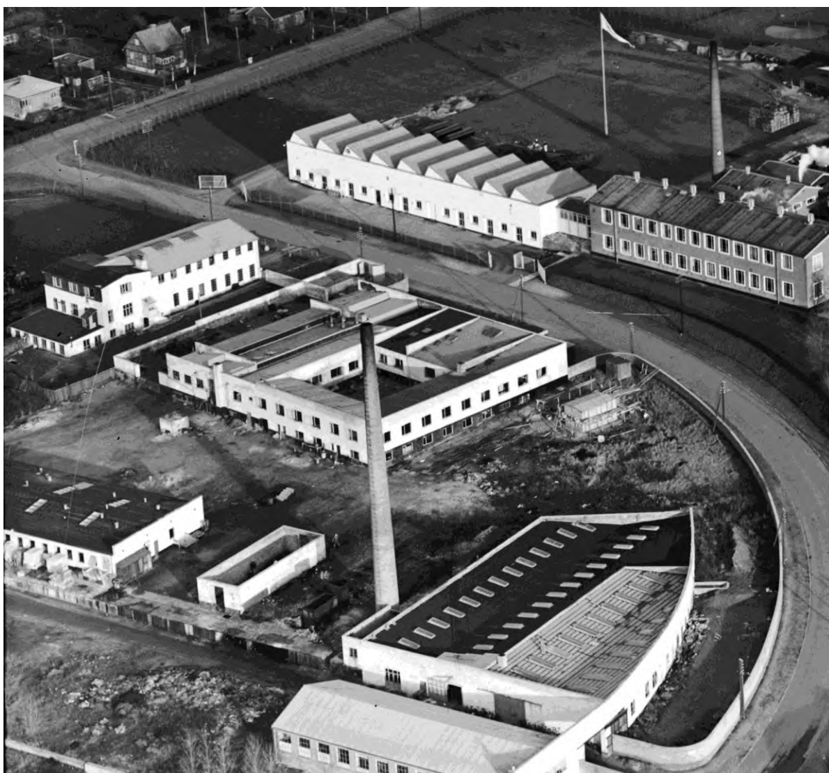
På få år havde Cheminova bygget et større fabrikskompleks, som ses midt på billedet fra 1947. På trods af adskillige brande og sabotager, måtte virksomheden købe en nabogrund, for at få tilstrækkelig plads til fabrikation af de eftertragtede erstatningsvarer. Fabrikken på den anden side af vejen er Ferrosan, som i øvrigt også begyndte at fremstille pesticider. Bemærk, hvor tæt privatboliger lå på den stinkende fabrik (Udsnit af foto, Nowico, Det Kongelige Bibliotek).
