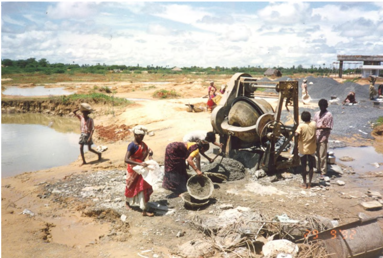
Indien – 1992. Kølehus til rejefarm i Nellore i deltagen Andra Pradesh. Billedet viser indiske arbejdere i gang med betonblanding. Foto: Preben Emil Olsen.
