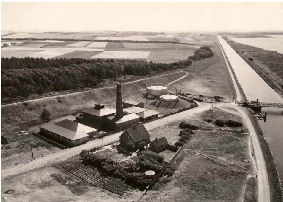
Løgstør Gasværk med Frederik den 7.'s Kanal til højre i 1935. Løgstør Lokalarkiv.
