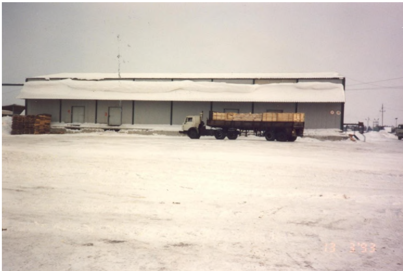
Rusland – 1993. Kølehus i Muravlenko i Sibirien ca. 120 km. fra Noyabrsk. Her renoverede Sabro køleanlæggene, som oprindeligt var leveret fra DDR. Foto: Preben Emil Olsen.
