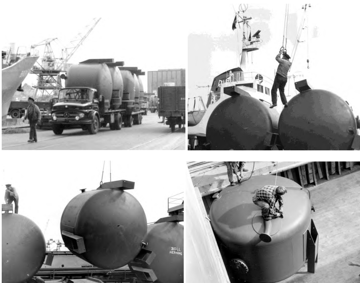
Lastningen af de 16 tanke fra Boll i Herning på skibet Bremer Reeder i 1971. Det er "Millimeter-Viggo" i kranen. Fotos: Ole Ryolf.
