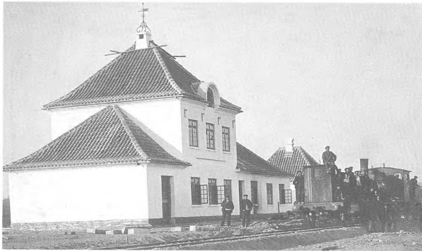
Farsø station under bygning, 1910. (LA)
