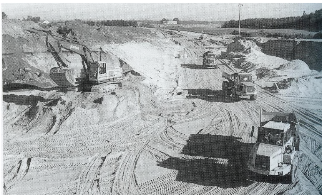
Der arbejdes på motorvejen nord for Hjallerupvej. (foto: Bent Baumann Jensen).
