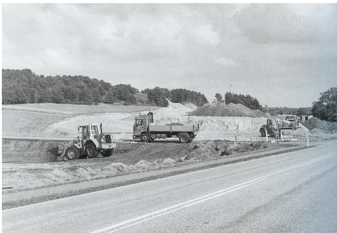
Arbejde på omfartsvejen der; hvor vejen til Try og Thorup krydser amtsvejen. (foto: Bent Baumann Jensen).
