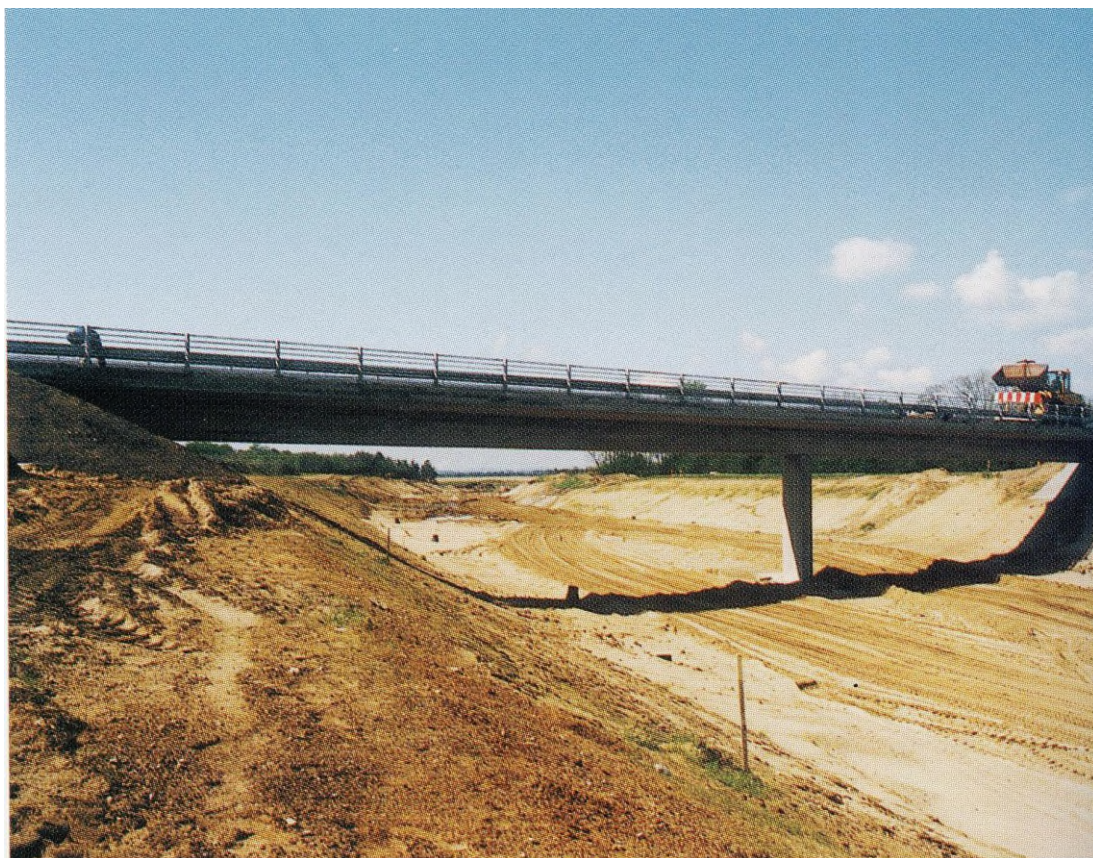
Broen, der fører Skelbakvej over motorvejen. (foto: Leif Kristensen).
