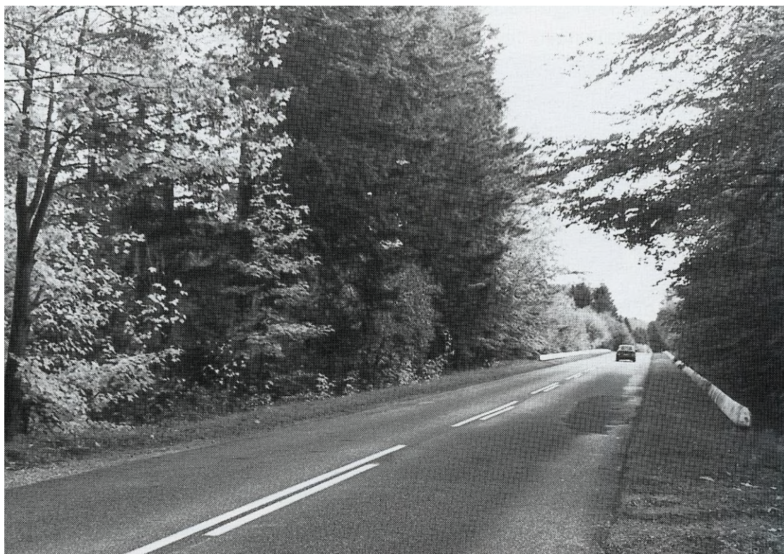
Asfaltvejen gennem Storskoven. (foto: Bent Baumann Jensen).
