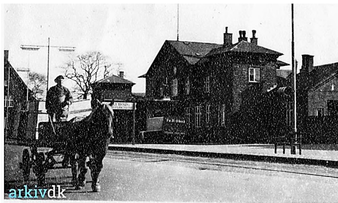
1 af 1 - Stationen set fra Drewsensvej
