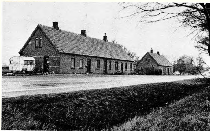
Grundmurede landarbejderboliger fra slutningen af 1800-tallet under Birkendegård ved Kalundborg. Det er et eksempel på, hvorledes mange af datidens landarbejdere boede i tilknytning til herregårdsmiljøet, og at de endnu kan ses forskellige steder i landet. Foto: G. Solvang 1982.
