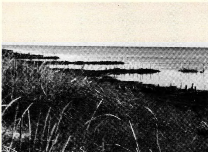
Høfder til beskyttelse af Overgårds østdiger set mod nord fra skellet mellem Overgård og Julianeholm 1980. Nogle af pælene er løftet af isen.
