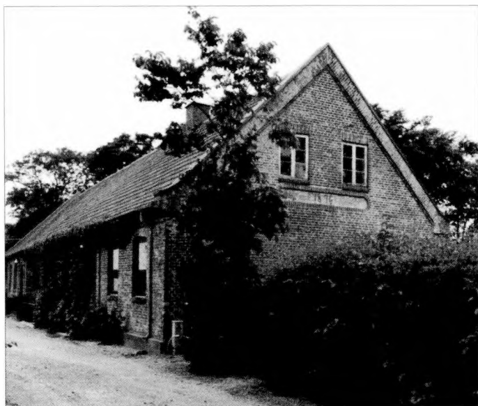
Gård opført i 1870'erne. Lyby, Salling.
