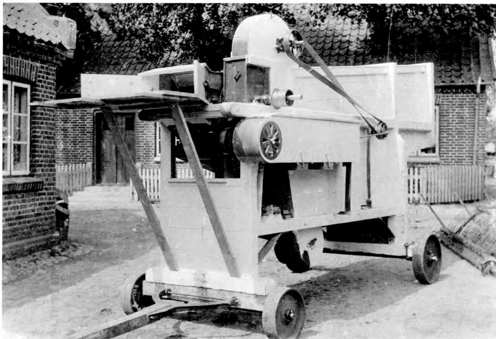
Fig. 10. Tærskéværk fra Anton Nielsens Maskinfabrik, Allingåbro. I perioden 1880 til ca. 1920 steg antallet af små maskinfabriker. En gennemgang af de maskiner, som virksomhederne tilbød, viser et meget stort sammenfald. Det var tærskéværker, hestegange, rensmaskiner og i en periode stationære motorer, som var på listen sammen med en række mindre redskaber. Foto: Chr. J. Dørge, Allingåbro.
