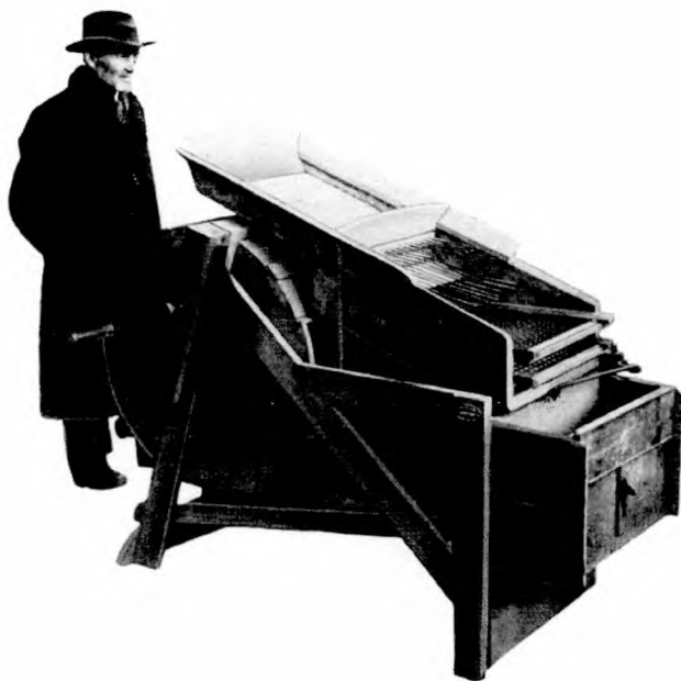
Fig. 8. N. Kr. Nielsen med sin rensemaskine fra 1894. Rensemaskiner havde sin 1820'erne fået en kolossal udbredelse i det danske landbrug. Niensens rensemaskiner tilførte landbruget en ny generation af rensemaskiner, som også blev brugt til kastning af kornet. Nielsen grundlagde Dronningborg Maskinfabrik i 1894. Illustration fra 50 Aar i Landbrugets Tjeneste, 1944.
