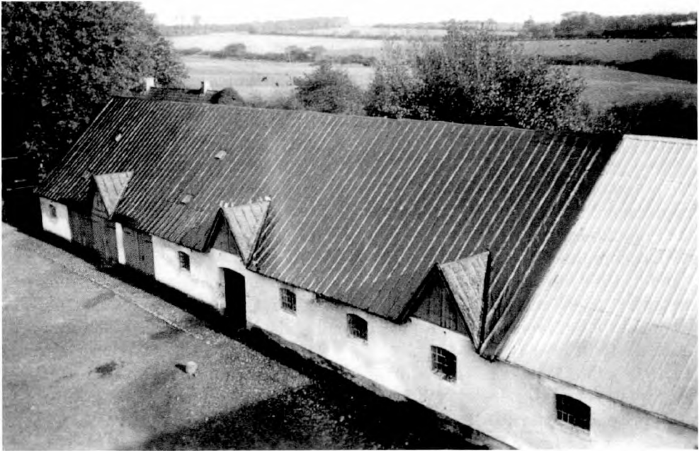
Fig. 15. Den gamle hestestald på Phønixborg fra 1886 i grundmur med kviste til indstikning af hø eller oplag af kornsække. Vinduer i støbejern og nyere bliktag. Nedrevet 1987. Privatfoto.
