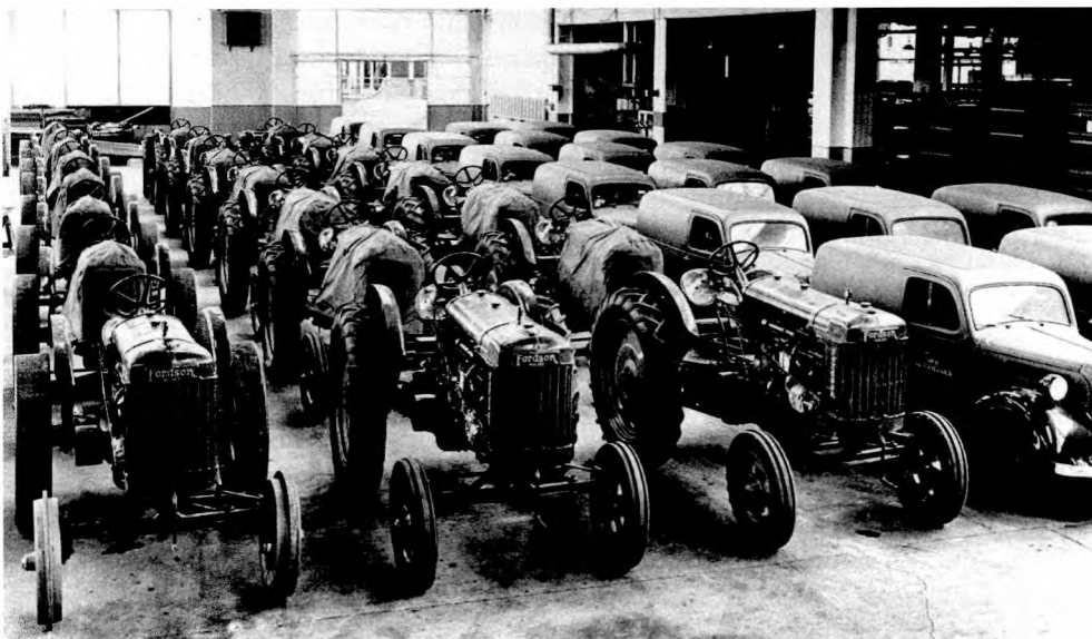
Fig. 2. Engelske Fordson Major traktorer under klargøring på vej ud til danske landmænd under Marshallhjælpen 1948-52. Traktorerne var ikke særlig raffinerede – stort set samme modeller, som forlod samlebåndene i 1939. De første blev således leveret uden selvstarter. De var tunge at håndtere, hvorfor de fik tilnavnet Klods Major, men de var billige og gjorde god fyldest. Amerikanerne var noget utilfredse med, at man brugte deres gavedollars til at købe engelsk, selvom det var helt efter bogen, da Marshallmidlerne ikke var bundet til køb i noget bestemt land.
