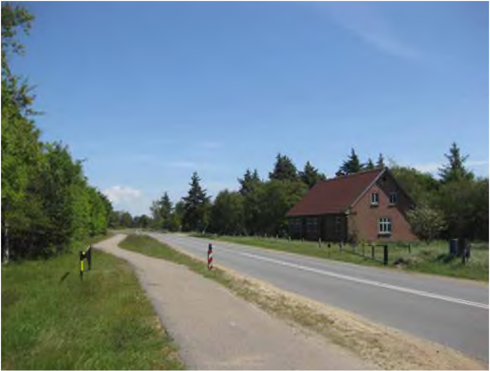
Figur 6. Området skulle fortsat se beboet ud. Her er det Vejers gamle skole, der blev opført i 1900 og fungerede indtil 1964. Bygningen er et godt eksempel på, hvorledes de gamle tomme bygninger tilfører landskabet historie og karakter, når de stadig vedligeholdes. Museet for Varde By og Omegn.
