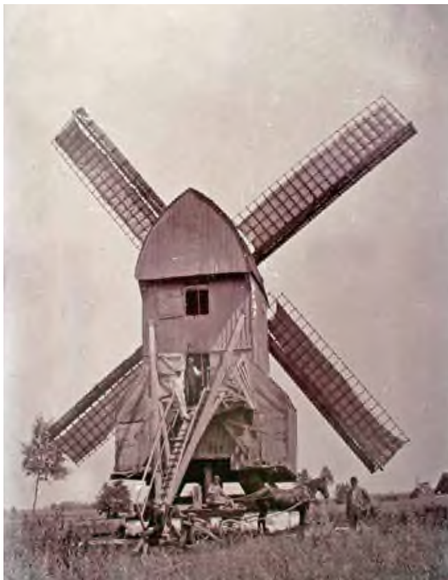
Figur 10: Hyllested Mølle fra Sorø-egnen. Et eksempel på hvordan man ved tilbygninger til mølleskroget forsøgte at skabe plads til noget af det inventar, som i 1800-tallet vandt indpas i stubmøllerne. Foto i Møllehistorisk Samling, Nordjyllands Historiske Museum.
