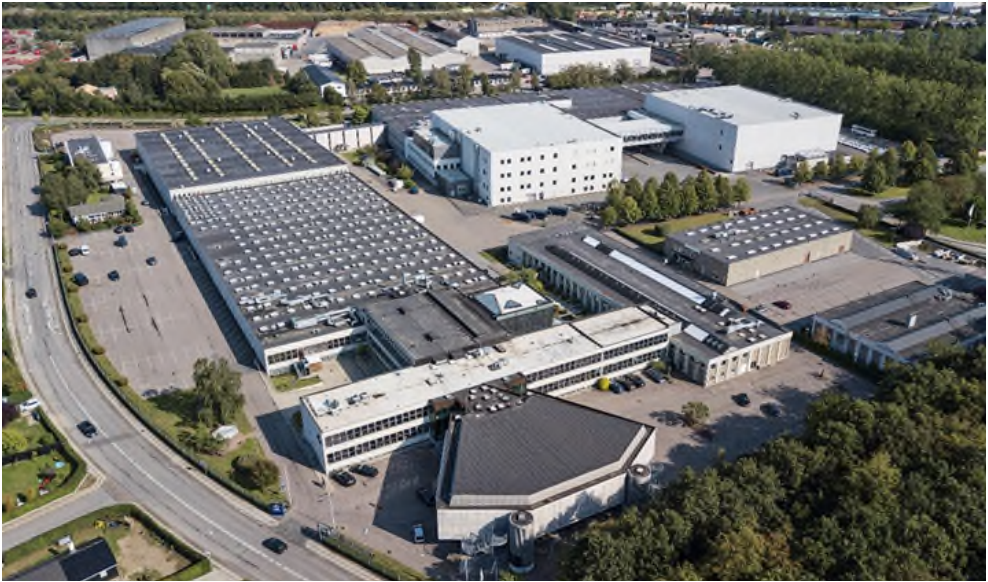
Figur 5. Auktionshuset i Glostrup med tilhørende lager, administrationsbygning m.m. Auktionshuset er løbende blevet udvidet og dækker i dag et areal på over 100.000 m 2 . Luftfoto af matrikel er taget af Kopenhagen Fur / Per Knudsen.
