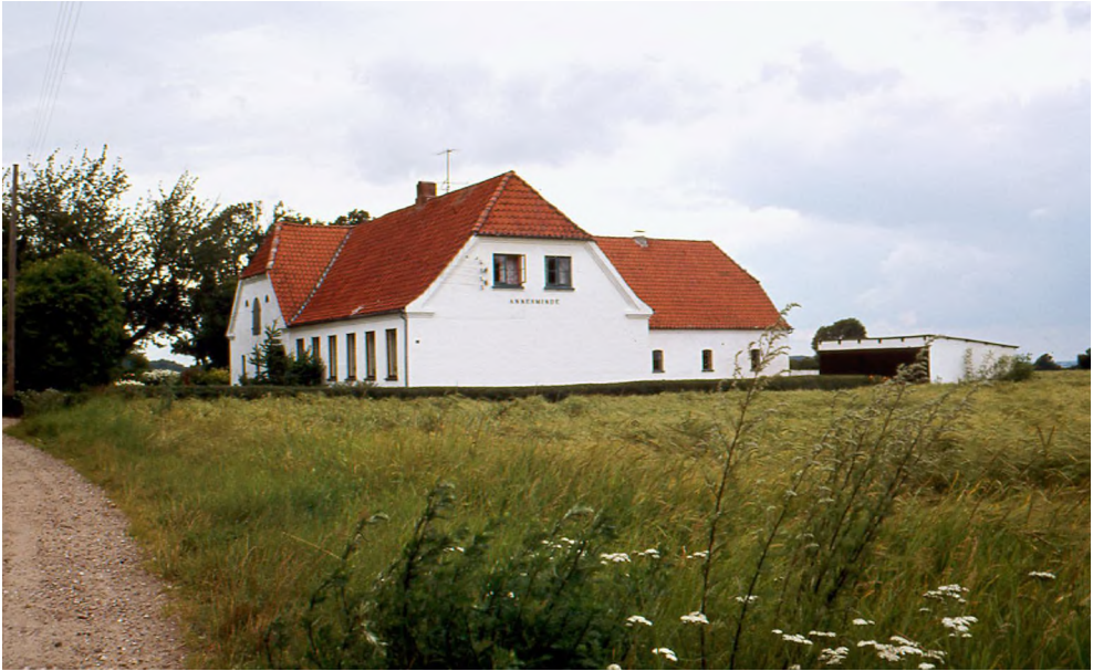
Figur 21. Arnkilsøre 7 – et af de nedlagte husmandsbrug i 1976 yderst på Arnkil opført i Bedre Byggeskik. De hvide vinkelbygninger med de røde tegltage, som var et gennemgående arkitektonisk træk i 26 af koloniens oprindelige brug, blev et nyt islæt i kulturlandskabet efter Genforeningen i 1920. Foto: G. Solvang.
