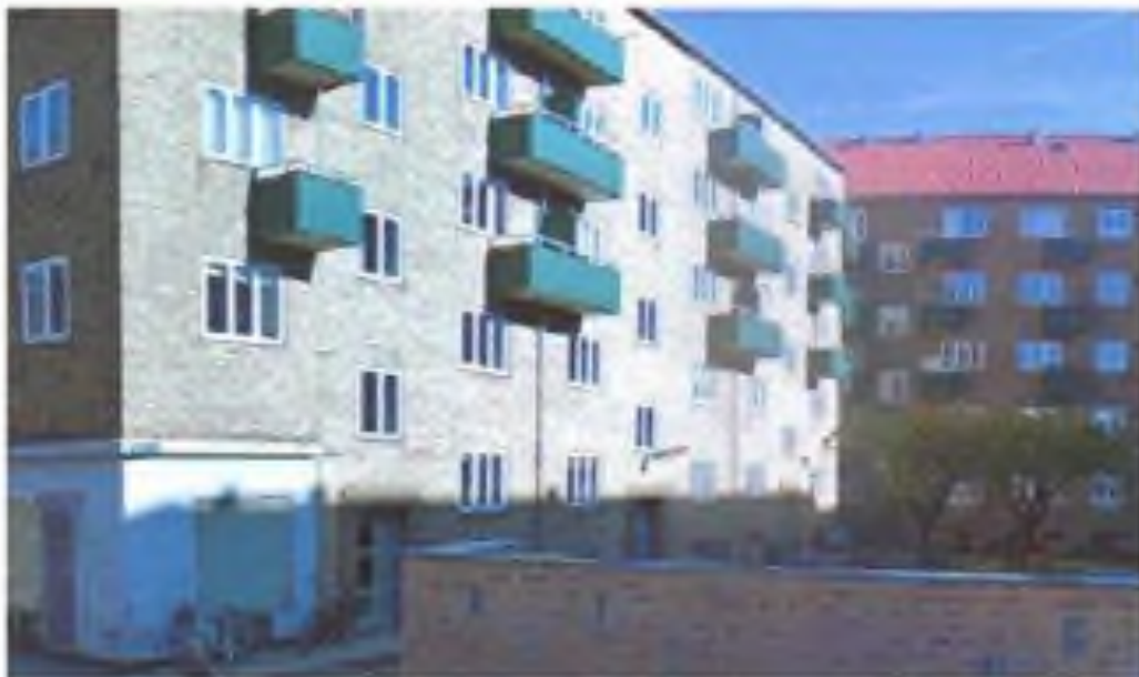
Grækenlandsvej 8,1 th.,Amager. Dengang uden altaner.
