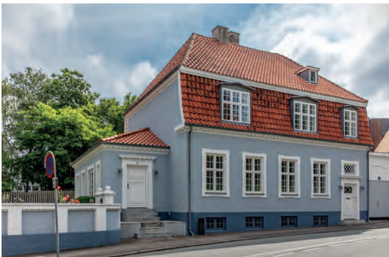
Herrestræde 8, Slagelse. Opført 1923. SAVE 3
