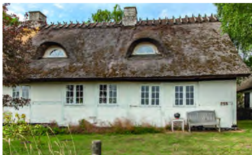
Hvidkalket bindingsværk 'over stok og sten' i den sjællandske tradition
