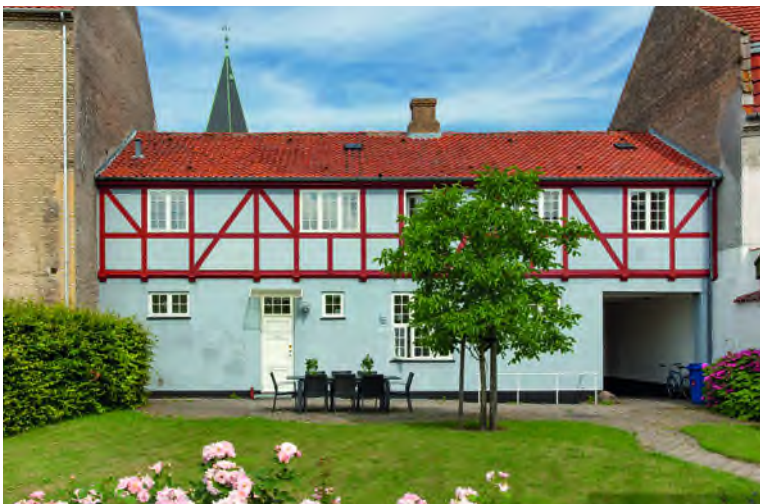
Bredegade 17, Slagelse. Opført 1800. SAVE 4, hhv. gade- og gårdside.
