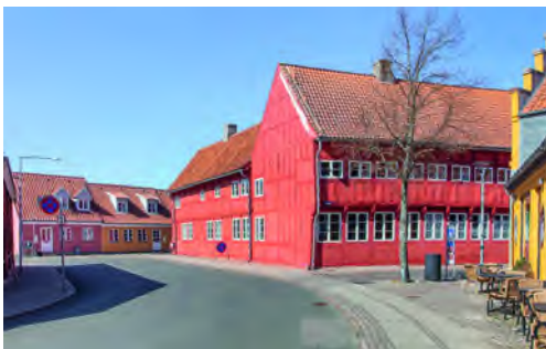
Stapels Gård, Algade i Korsør. Opført 1667. Fredet.
