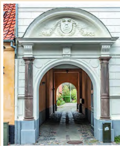
En port i Algade i Skælskør er markeret med halvsøjler – og rund frontispice.
