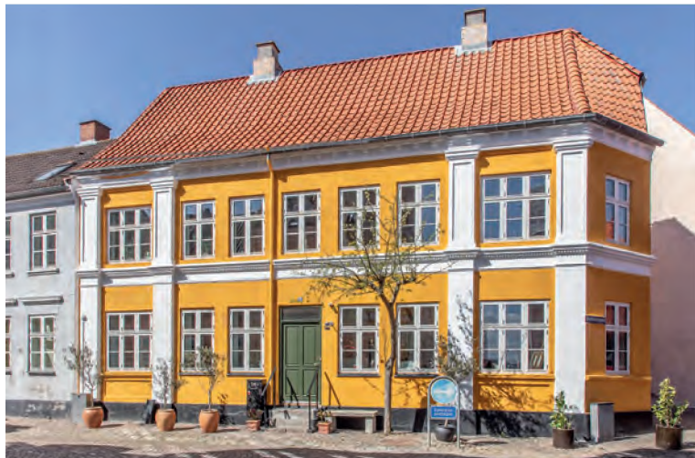
Slottensgade 16, Korsør. Opført 1903. SAVE 3
