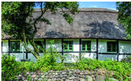
Hvidkalket tavl, optegnet bindingsværk.
