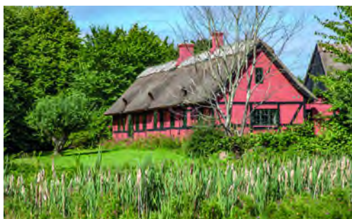
Rødkalket tavl, optegnet bindingsværk.
