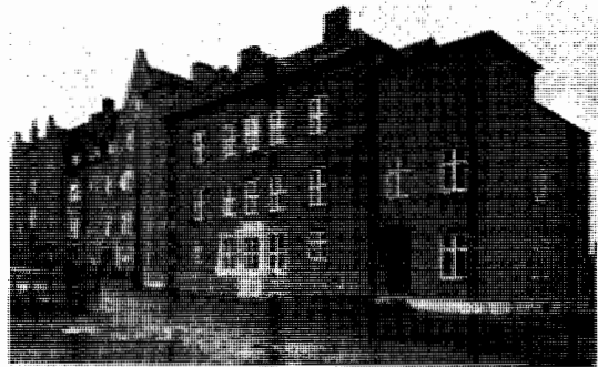
SKT. MARIA HOSPITAL I VEJLE efter de sidste Udv delser Helt tv. den ældste Del (med de to Frontispicer); i Tilslutning hertil Fløjen af 1927/29 (bemærk Indkørslen til Sygeelevatoren og den nederste Frontispice, som halvvejs er dækket af „Smøge Fløjen“); og endelig den sidste Udvidelse 1937, hvis Kærne dannes af den gamle Skole.
