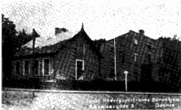
ST. HEDVIGSSØSTRENE BØRNEHJEM I ODENSE. Den nøgne Façade paa Tilbygningen blev senere gen-nembrudt af Vinduer og Døre ud til Altanen.
