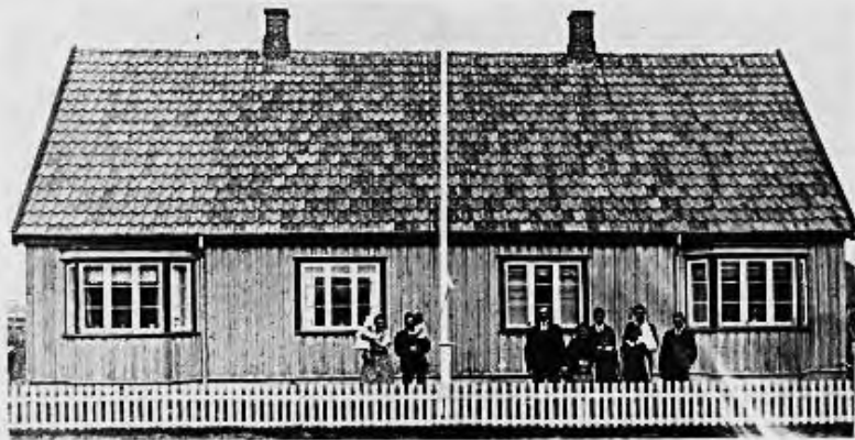
Chauffør Hans Hansen og hans svigersøn lånte hver 500 kroner og købte grundene Hødersvej 7 og 9. For at spare på tømmeret lod de husene hænge sammen. Foto ca. 1925.
