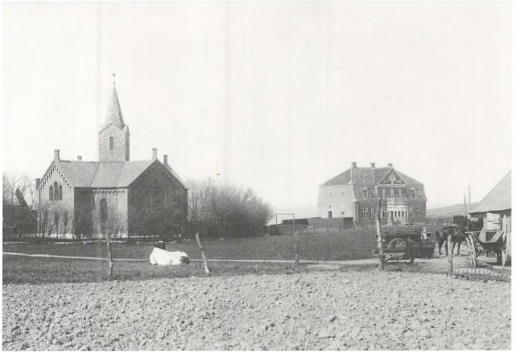
Lemvig Møllegårds jorder omkring 1905. Til venstre ligger Valgmenighedskirken, opført 1883 af den grundtvigianske menighed. I midten Vandbygningsvæsenets hovedkontor, bygget 1904. Til højre et hjørne af Møllegårdens udlænger. (Lemvig Museum).
