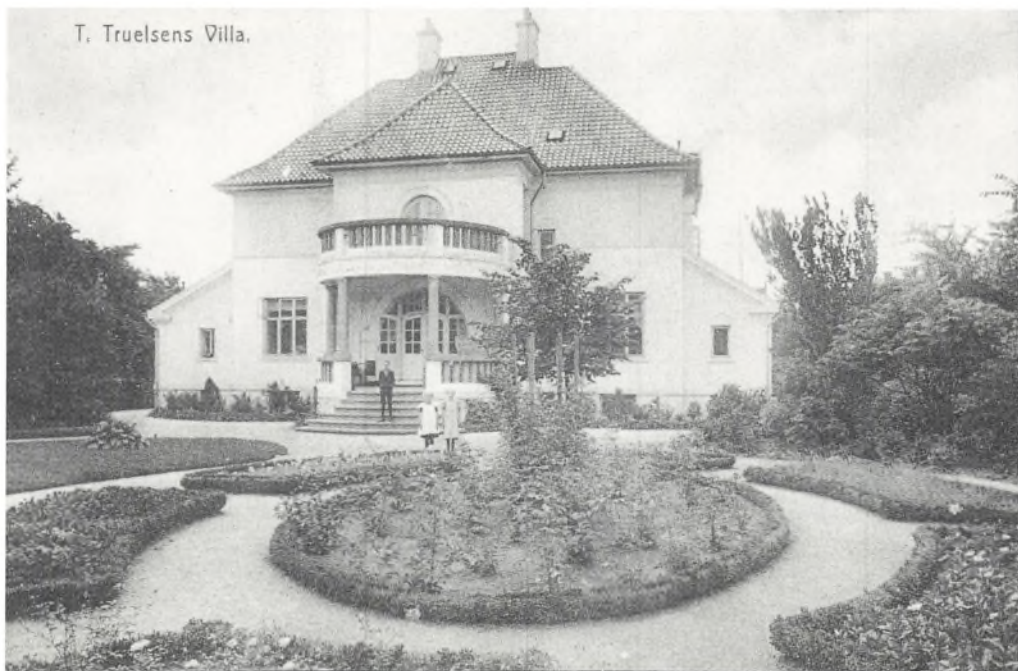
T. Truel sen.s villa få år efter opførelsen i 1906. De sirligt anlagte rosenbede omkransede af buksbom var typiske for den tid.
