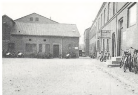
Fabriksgårdens nordlige del med kontor- og lagerbygninger til højre. I den lave tværbygning var der i sin tid vognport og hestestald.
